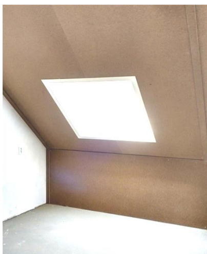
Voorbeeld afwerking hellend dak: niet afgewerkte binnenplaat
